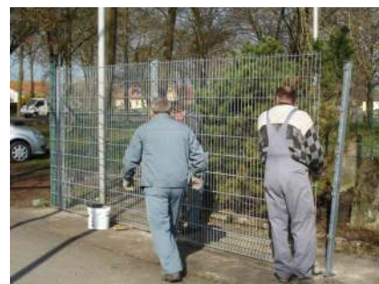
Der neue Zaun wird aufgebaut
