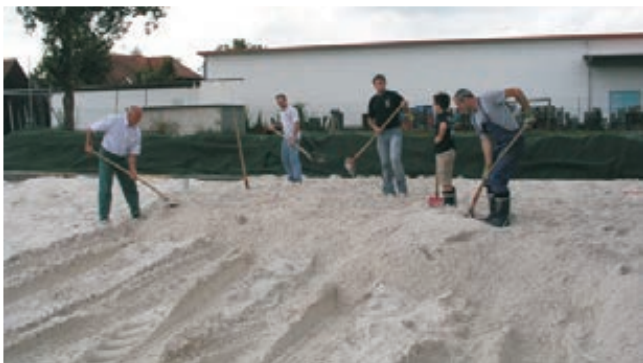
Bau des Beachvolleyballplatzes
